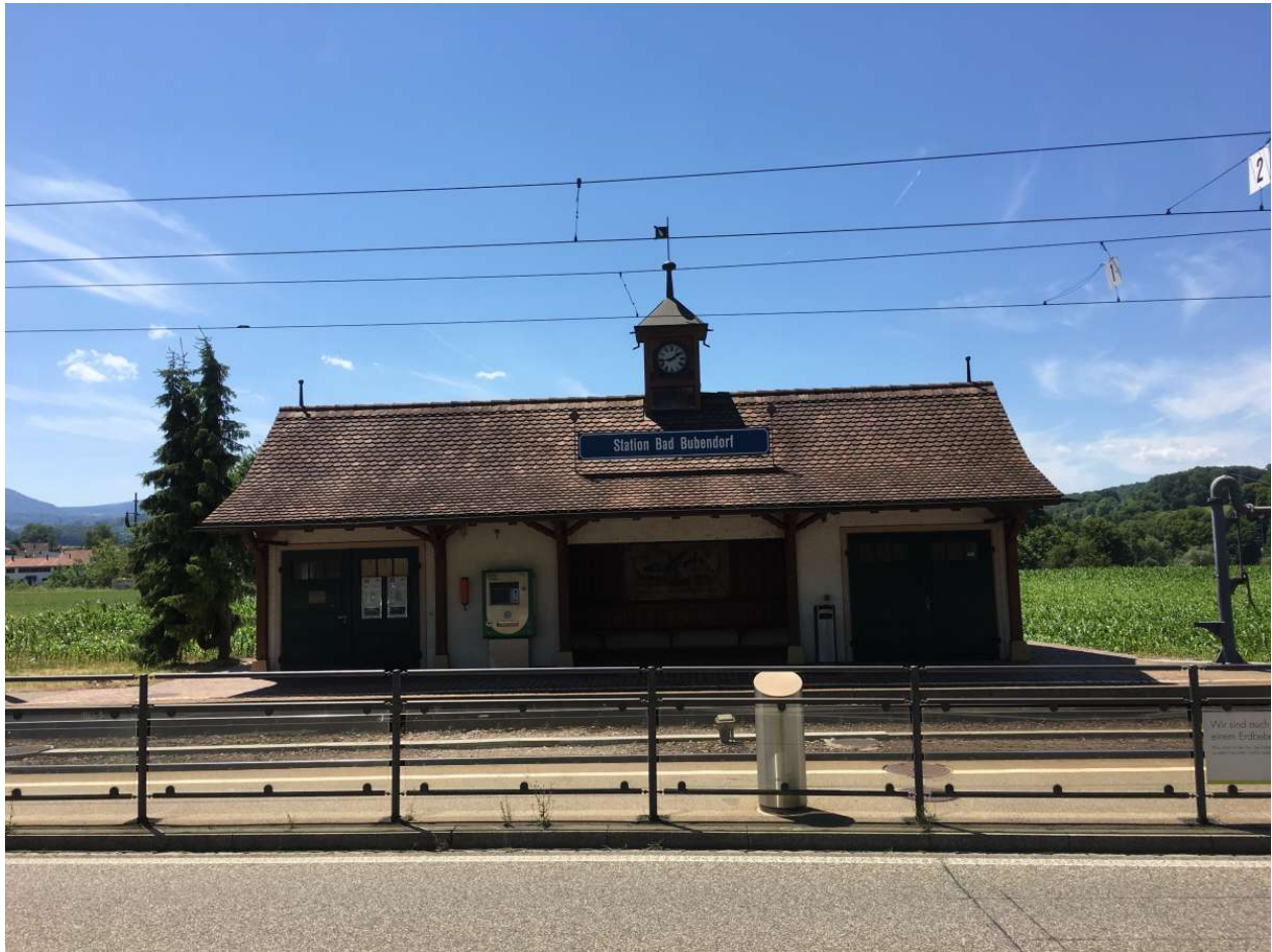
Die Station Bad Bubendorf vis-à-vis des Hotels.
